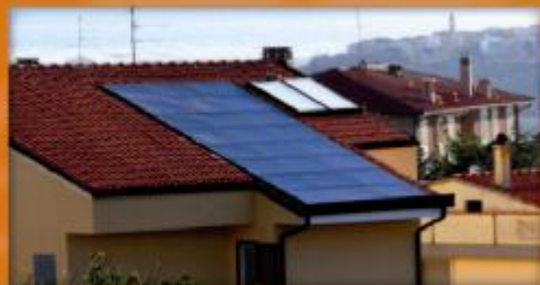
Impianto da 4,2 kWp Architettonicamente Integrato Termoli (CB)
